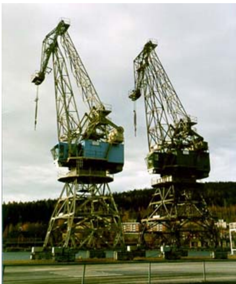
Hamnkranarna vid Örnköldsviks hamn.
